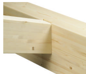
Meias-vigas fixadas em viga de sustentação
