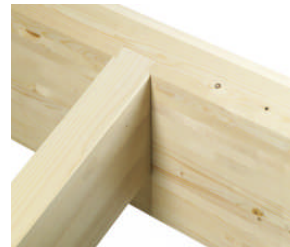
Meia-viga em viga de telhado desbastado
