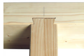
Viga aparente em suporte
