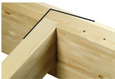
Chevron sur panne faîtière
