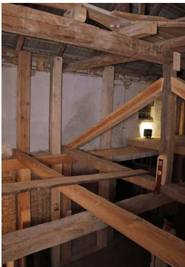
MAFELL Soba 2017 Kornhaus Details.jpg
