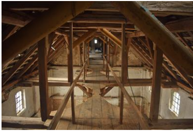
MAFELL Soba 2017 Kornhaus vorher.jpg
