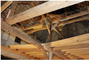
MAFELL Soba 2017 Kornhaus nachher.jpg
