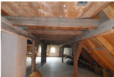
MAFELL Soba 2017 Dachstuhl.jpg
